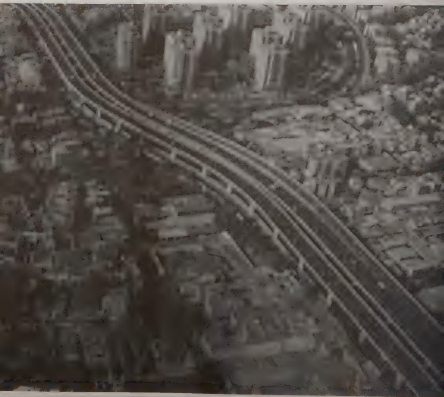
2005. Segundo piso del Periférico.
